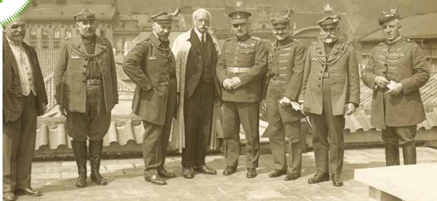
Historický snímek zachycuje delegaci polských sokolů s architektem Fr. Krásným na střeše Tyršova domu
